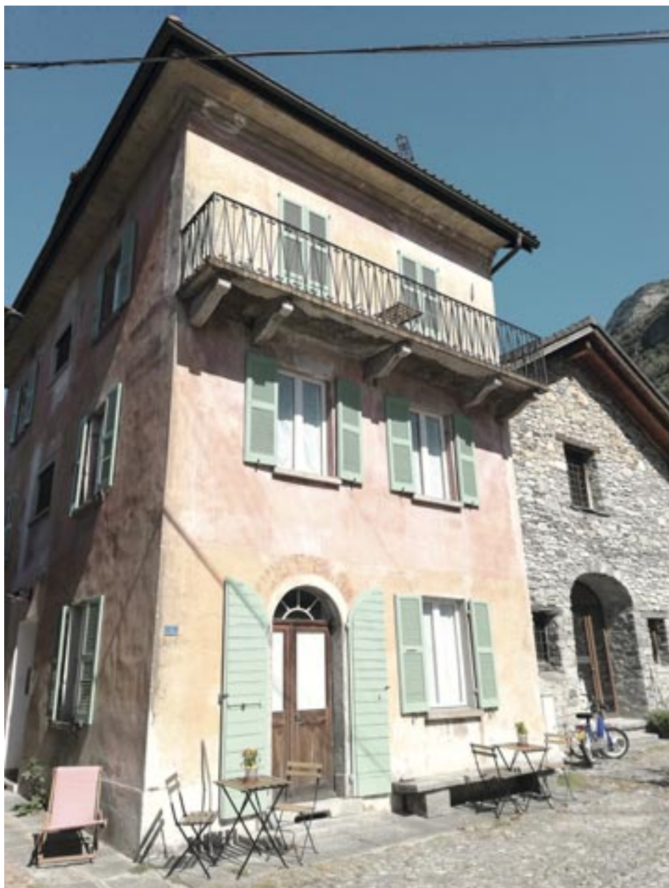
La casa Vino e Birra sulla piazza di Osogna, ristrutturata da Clara e Davide Conceprio, che ora ospita turisti e viaggiatori.
